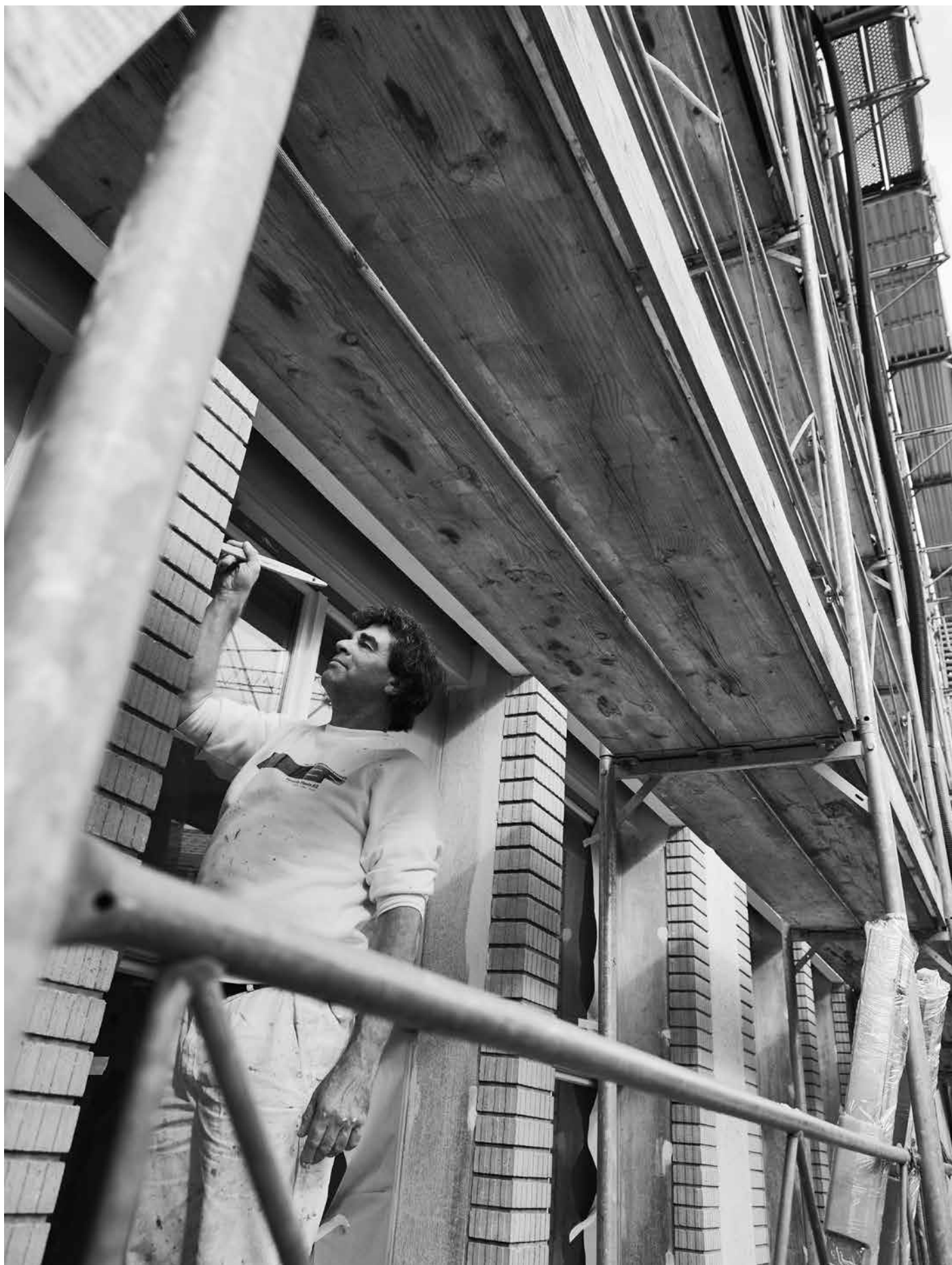
Sanierung und Neubau des Schulhauses Geissenstein.
