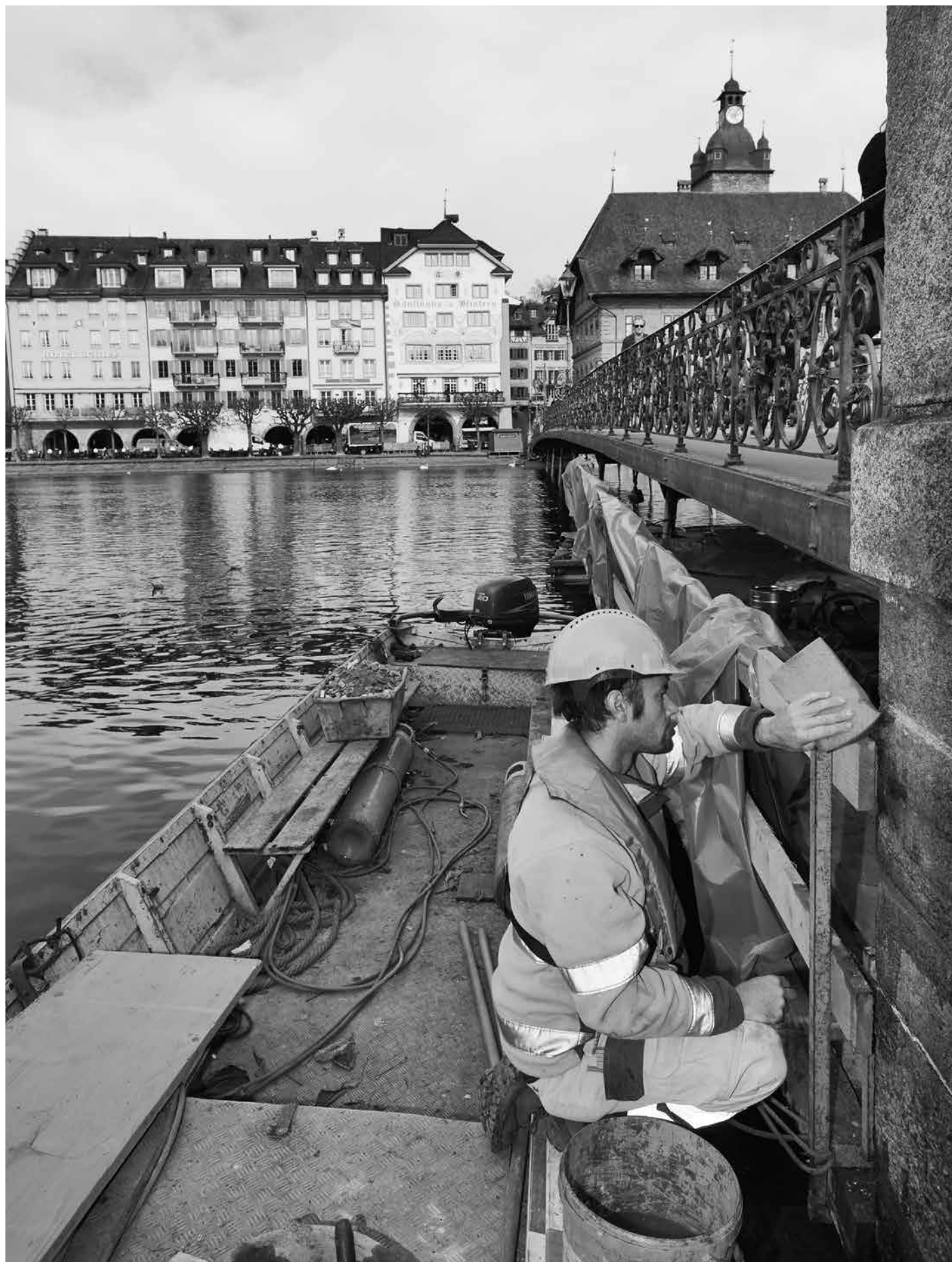
Sanierung des Rathausstegs.
