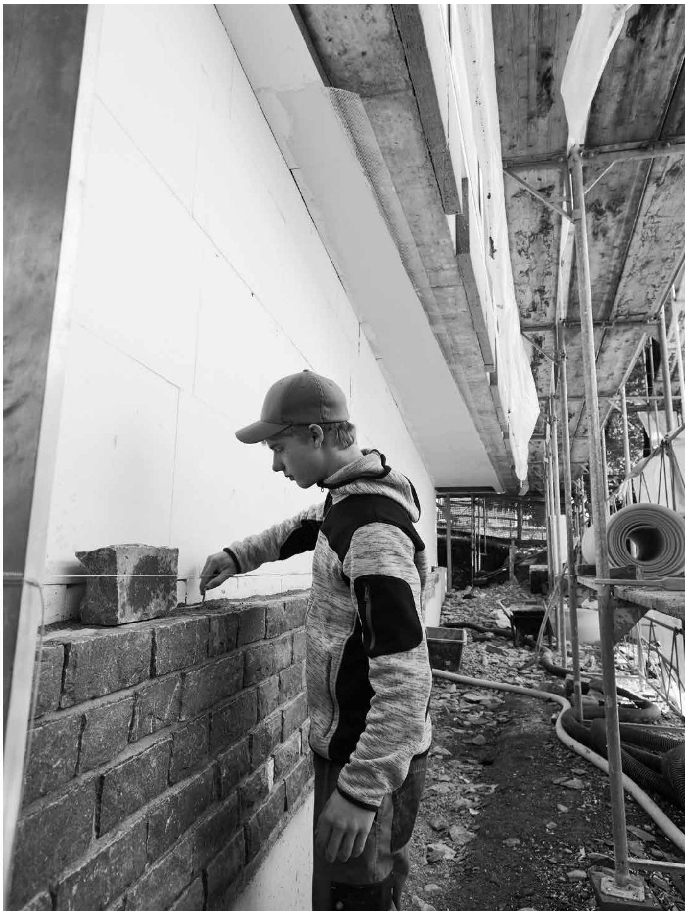
Gesamtsanierung und Ausbau der Schulanlage Felsberg.
