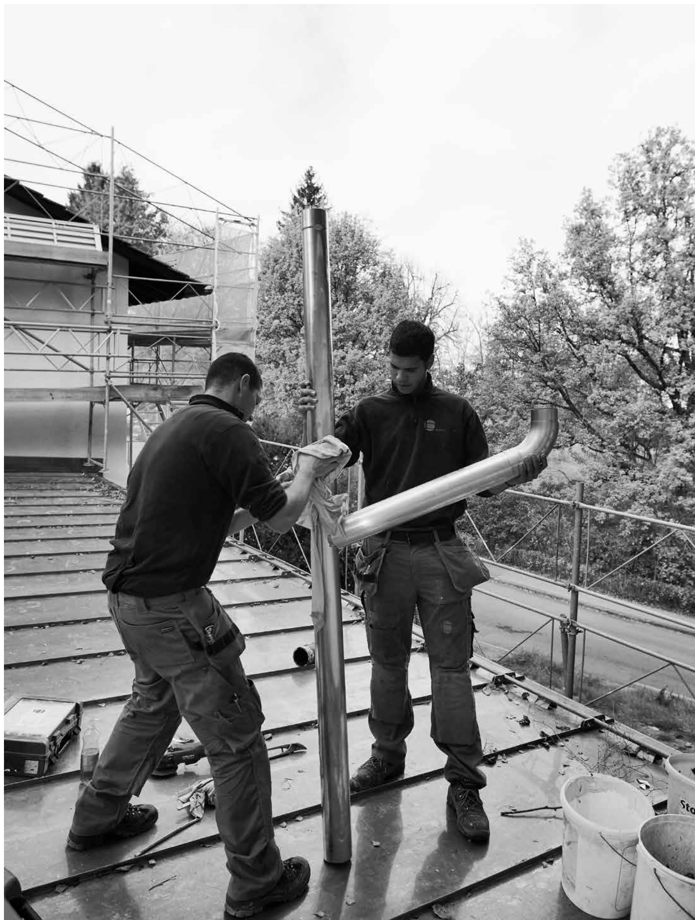
Sanierung und Neubau des Schulhauses Geissenstein.
