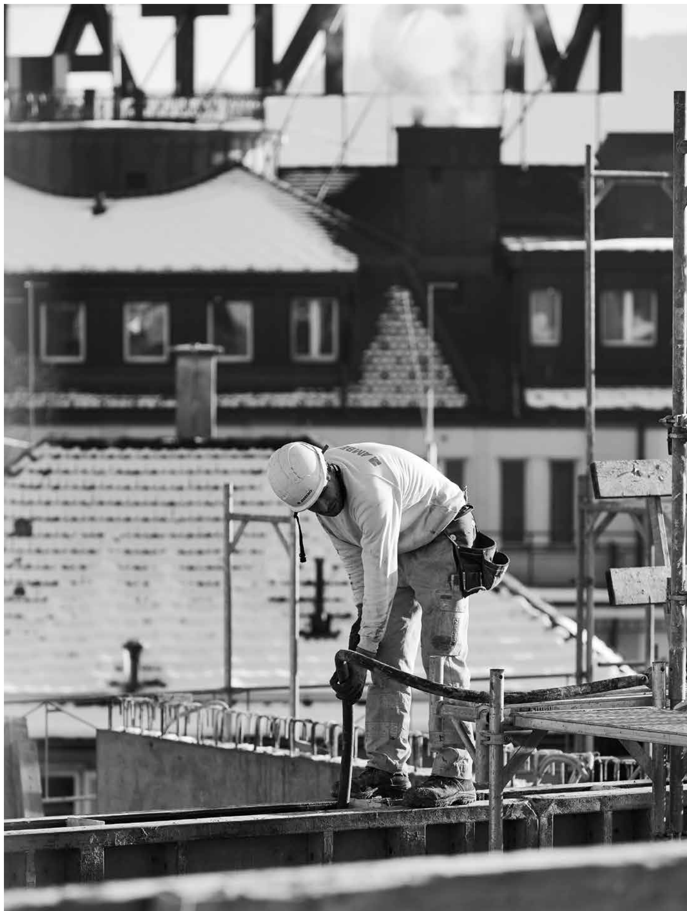
Bauarbeiten für das Betagtenzentrum Dreilinden.
