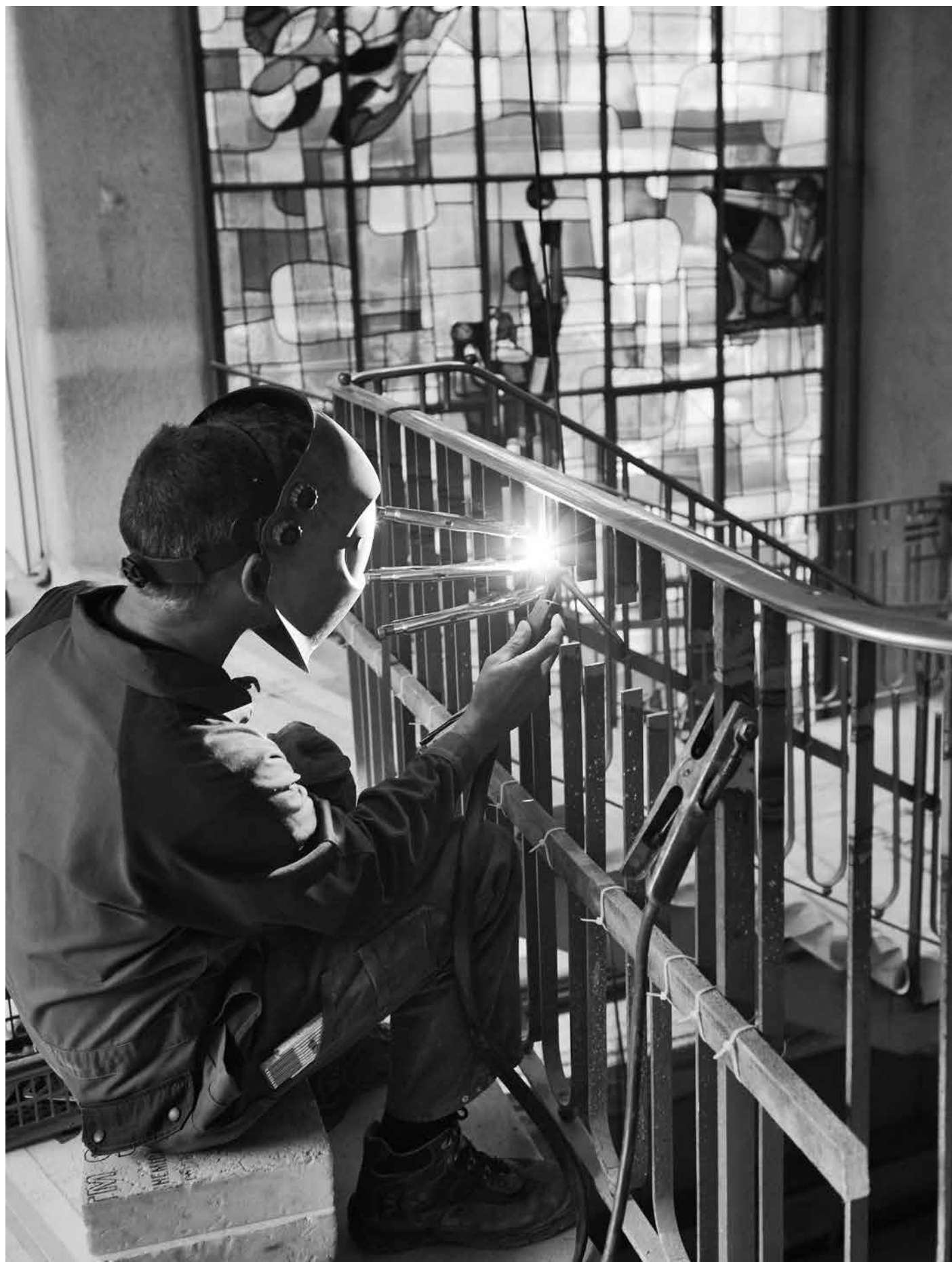
Sanierung und Neubau des Schulhauses Geissenstein.
