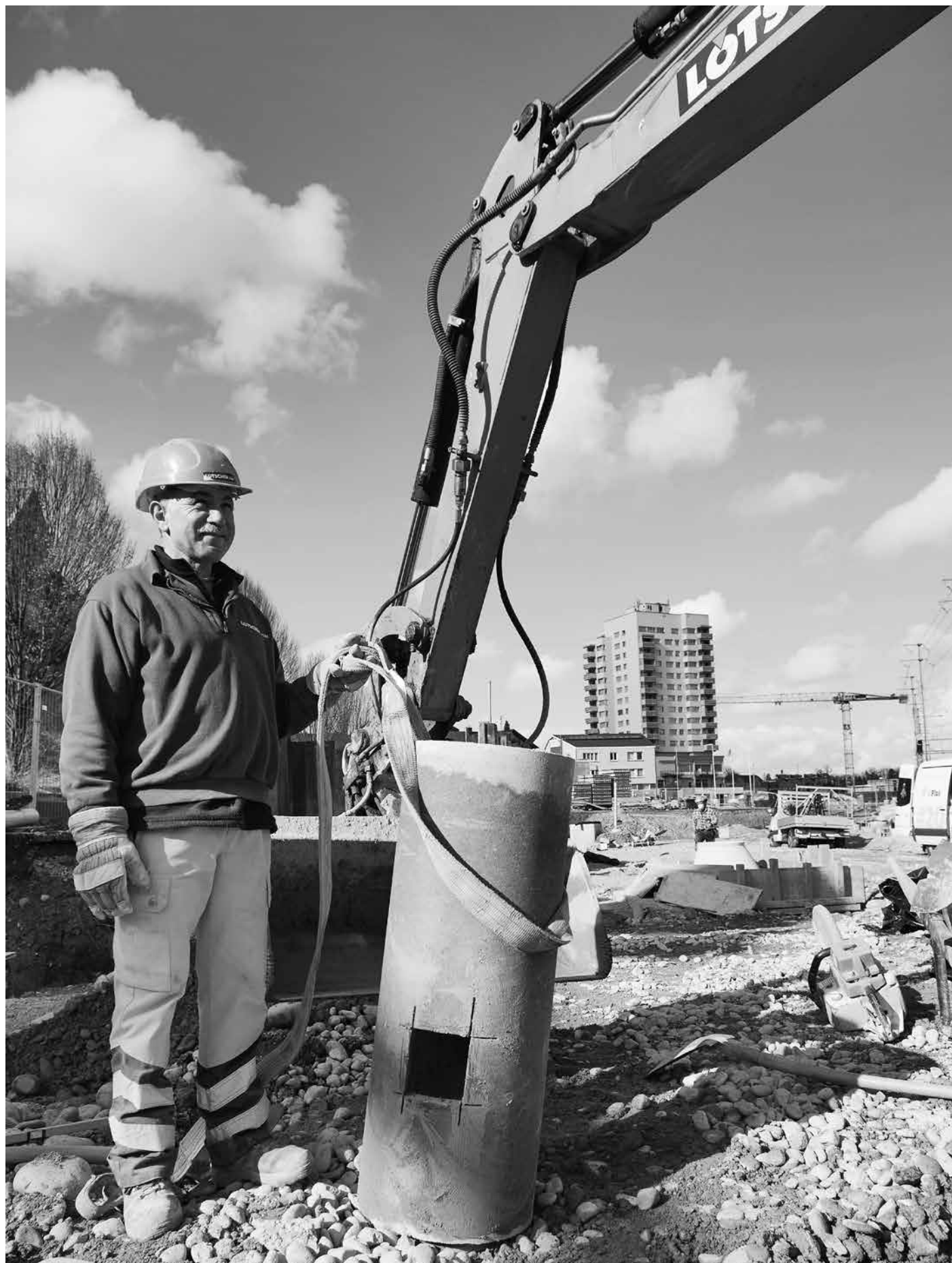
Gesamtprojekt Luzern Nord: Bauarbeiten in Reussbühl.
