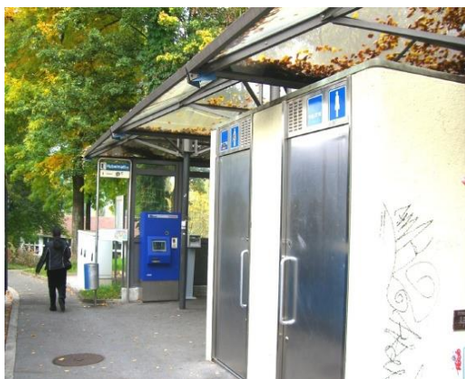
Abbildung 11: WC-Anlage vbl-Endstation Hubelmatt
