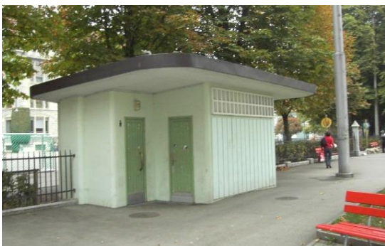
Abbildung 13: WC-Anlage Schulhaus Maihof / Schlossberg
