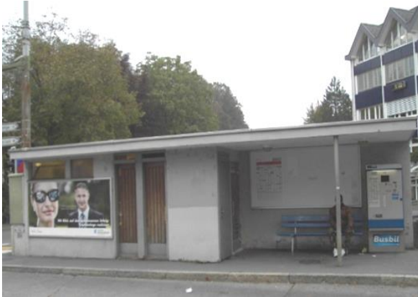
Abbildung 12: WC-Anlage vbl-Endstation Maihof
