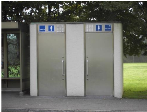
Abbildung 10: WC-Anlage vbl-Endstation Hirtenhof
