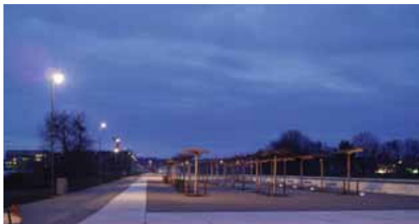
Beispiel: Beleuchtung Gehweg mit Masten
