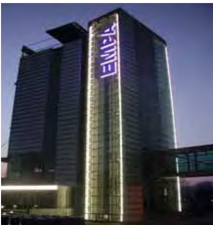
Beispiel: Beleuchtung Fassade
