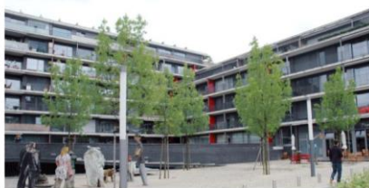
Abb. 7 - Betonung der Kragplatten im Hof Wohnsiedlung Tribschen Luzern, 2007, WIT Architekten Galli&Rudolf Architekten
