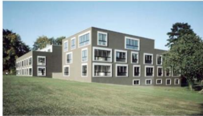
Abb. 5 - Monolytische Wirkung, Baukörper wachsen verschobene aus dem Terrain heraus Wohnsiedlung Broelberg Kirchberg, 1996, Gigon Guyer Pulver
