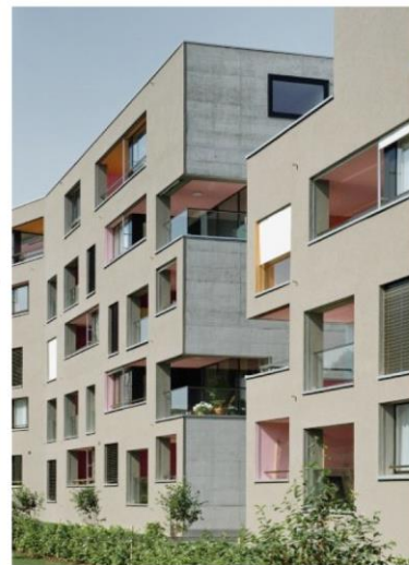
Abb. 6 - Betonung des muralen Charakters durch Fensteröffnungen Wohnsiedlung Chriesinatt, Baar, 2003, Graber und Pulver
