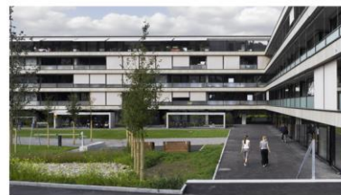
Abb. 8 - Betonung der Brüstungsbänder im Hof Wohnsiedlung Hofgarten, Zürich-Lembach, 2007,
