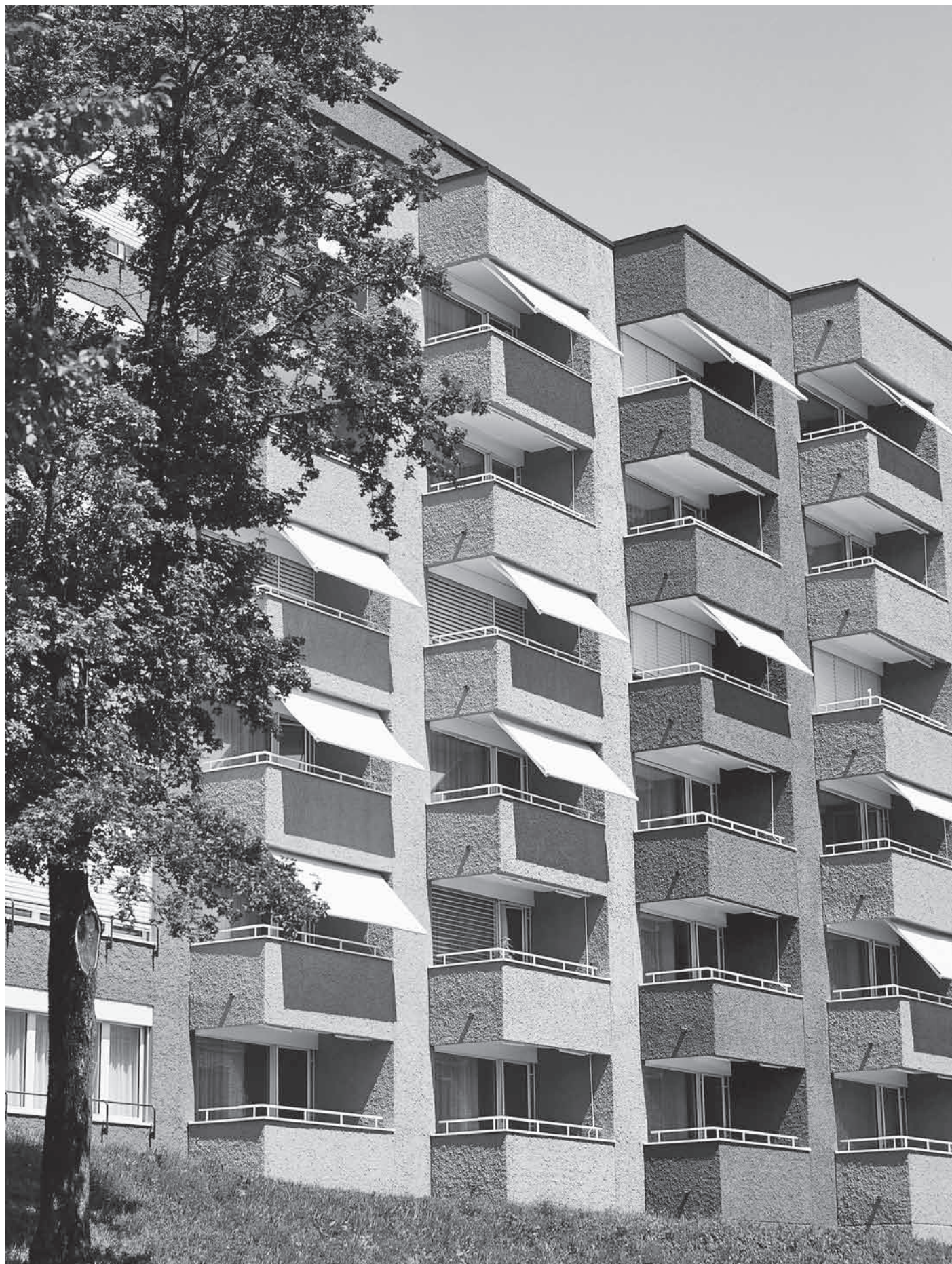
Das BZ Staffelhof in Reussbühl wurde gründlich saniert und erhielt einen neuen Anbau. Ende August 2013 wurde es wiedereröffnet.
