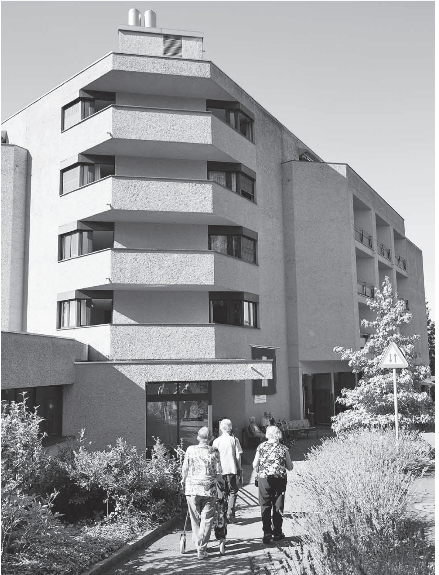
Das BZ Dreilinden ist eine moderne Alterswohnsiedlung an schönster Hanglage über der Stadt Luzern in einem ruhigen Wohnquartier.
