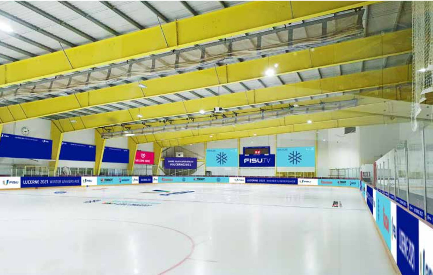
Die Eishalle Sursee verfügt dank der Vorbereitung auf die Winteruniversiade über eine neue moderne LED-Beleuchtung.
