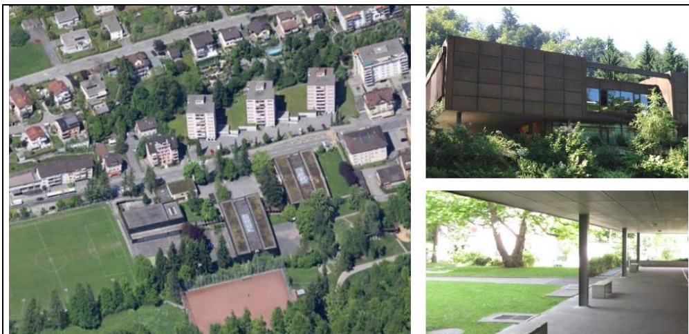
Luftbild und Fotos Schulanlage Grenzhof
