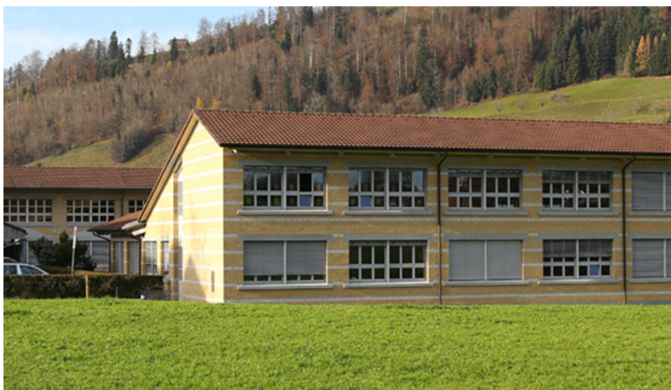
Abb. Schulhaus Obernau
