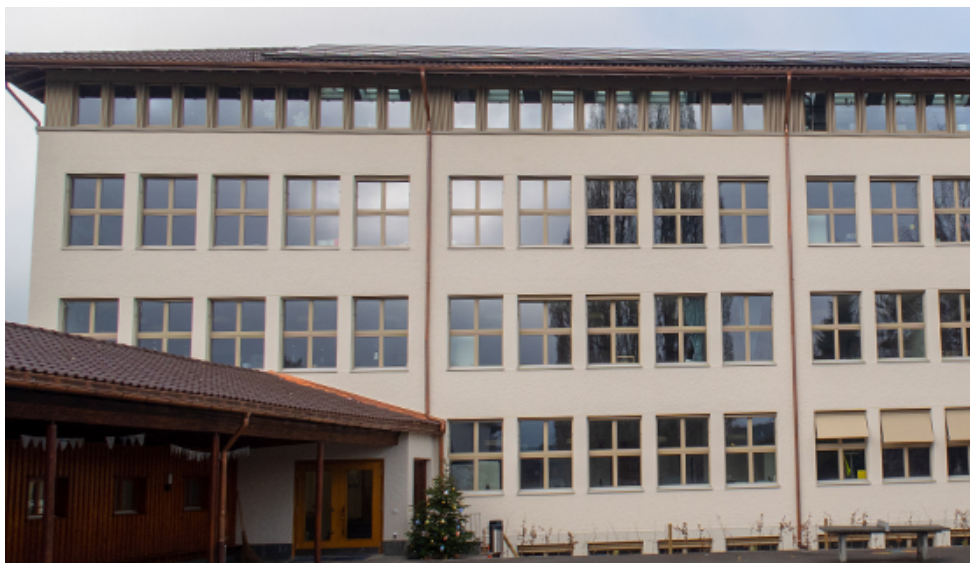
Abb. Schulhaus Brunnmatt
