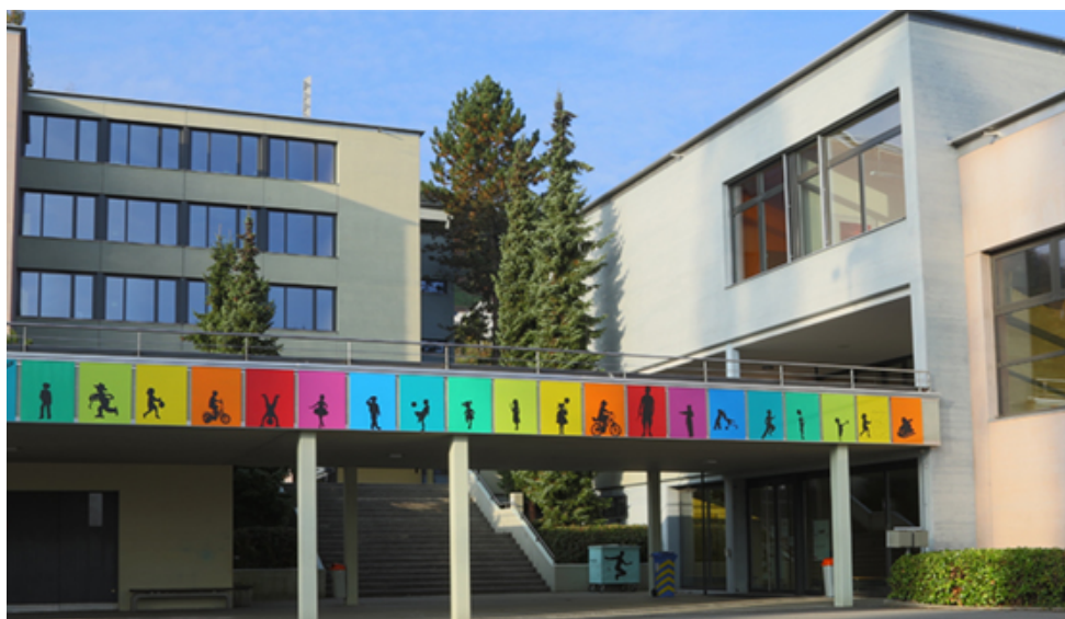
Abb. Schulhaus Roggern 1
