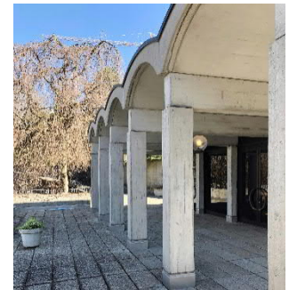
Abdankungsgebäude Carl Kramer Vorhalle heutiger Zustand
