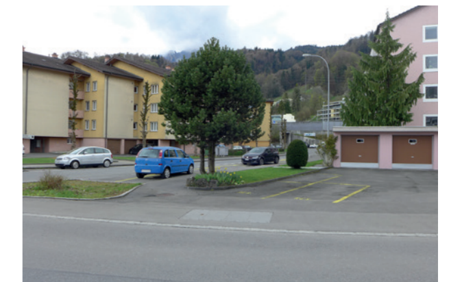
Mitte des Gevierts (Altsagenring Richtung Westen)
