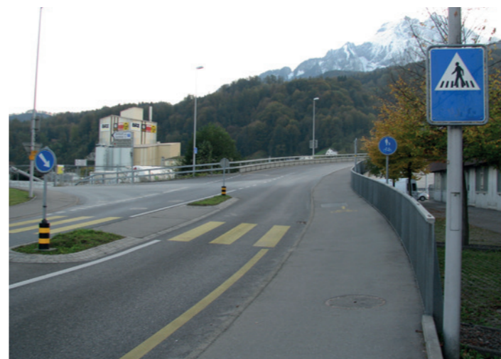
Brücke (Abschnitt 1) Richtung Technikumstrasse
