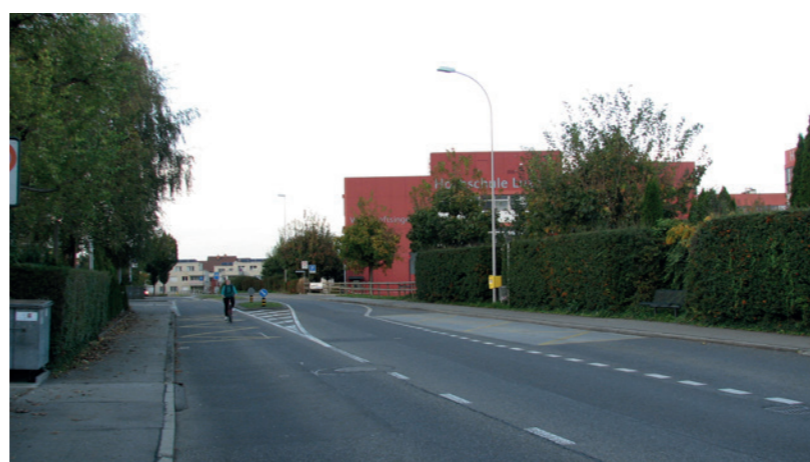
Technikumstrasse, Abschnitt B
