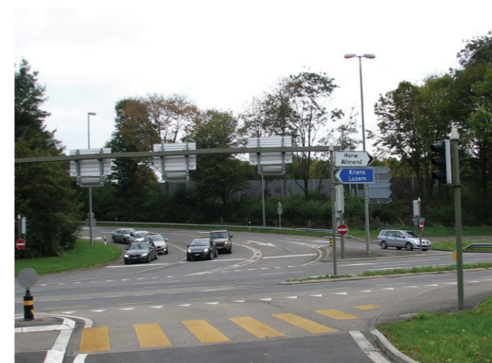
Autobahnabfahrt Luzern-Kriens (Eichwilstrasse) (Foto Team LuzernSüd)
