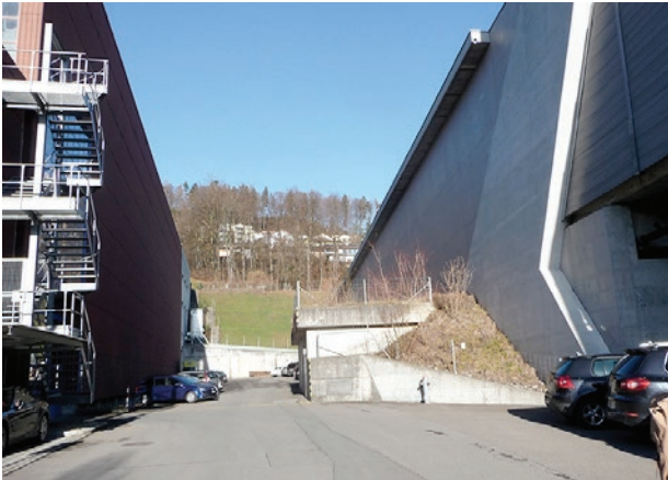
Rand A2 Portal Sonnenbergtunnel
