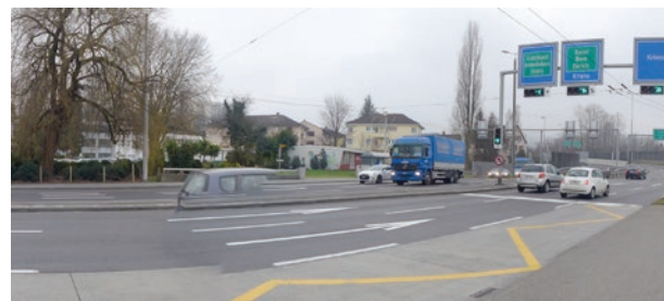
Blick von der Luzernerstrasse im Norden
