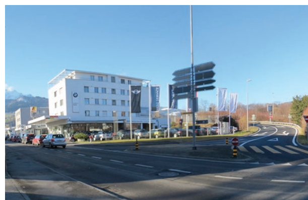
von Norden: Autobahnabfahrt, Autohaus Sigrist
