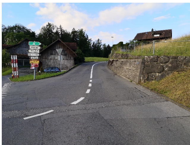
Abbildung 11: Bestehende Stützmauer Mättiwilstrasse
