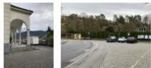
Bestandssituation: Hauptzugang Kirche, Bereich Familiengräber und Hauptbestattungstrasse
