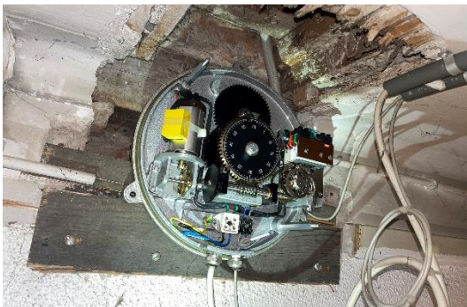
Abbildung 16: Sanierung Schulhausuhr
