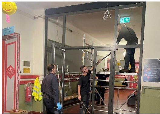
Abbildung 11: Einbau Brandschutztüren
