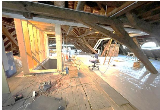
Abbildung 5: Erstellung Treppenaufgang und Dämmung
