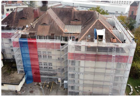
Abbildung 4: Sanierung Firstziegel 2. Etappe
