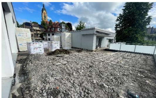
Abbildung 6: Sanierung Flachdach Kindergarten
