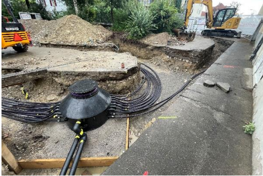
Abbildung 12: Leitungsbau für Erdsonden
