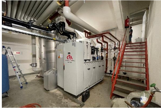
Abbildung 13: Einbau Wärmetauscher
