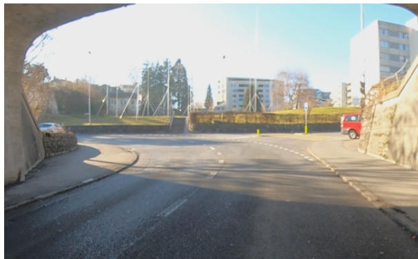
Abbildung 1: Gersagstrasse, Unterführung, Fahrtrichtung Kreisel
