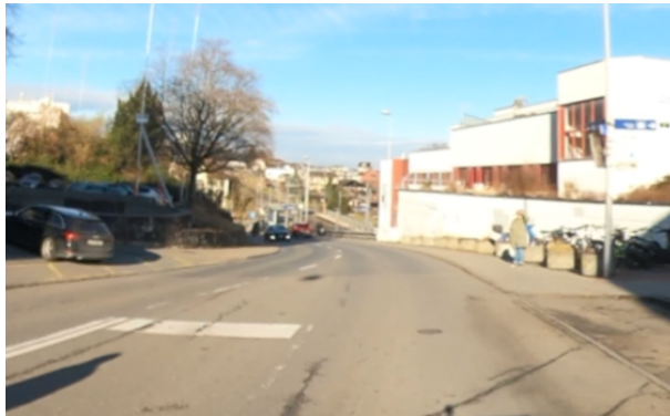
Abbildung 5: Gersagstrasse, Höhe Einmündung, Fahrtrichtung Rueggisingerstrasse
