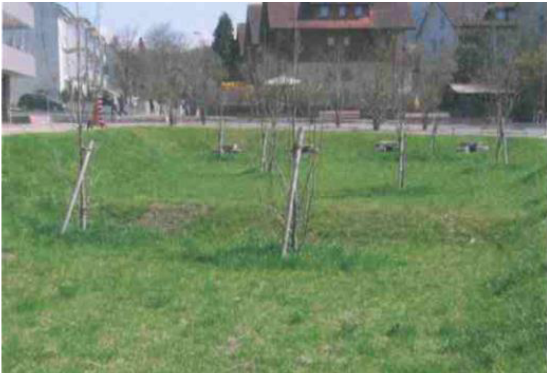
Abbildung 3: Beispiel Versickerungsmulde inkl. Retention (VSA)
