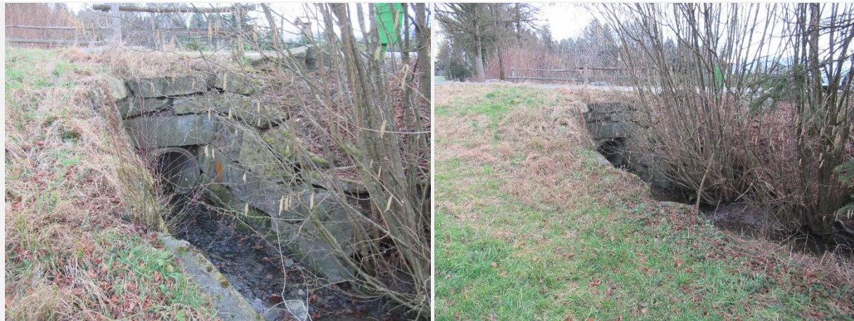
Einlaufbereich bei Durchlass Schlüsselstelle S1 (oeko-b ag, 10.02.2020).
