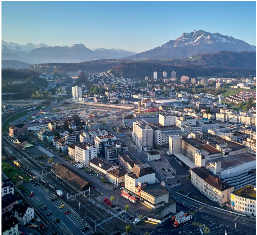
Abbildung 1: Luftbild Planungsperimeter (Vordergrund) mit Seetalplatz im Hintergrund
