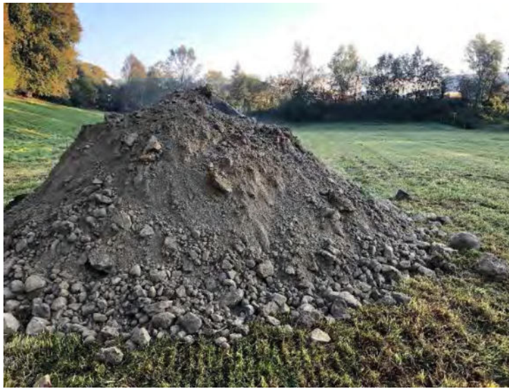
BS 2: Ausgehobenes Material, Blickrichtung N
