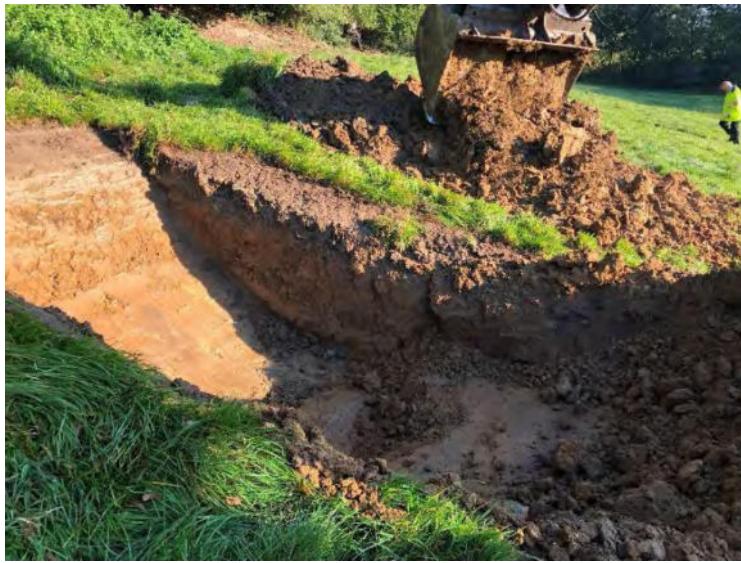
BS 3: Tiefe 1.00 m Blickrichtung N
