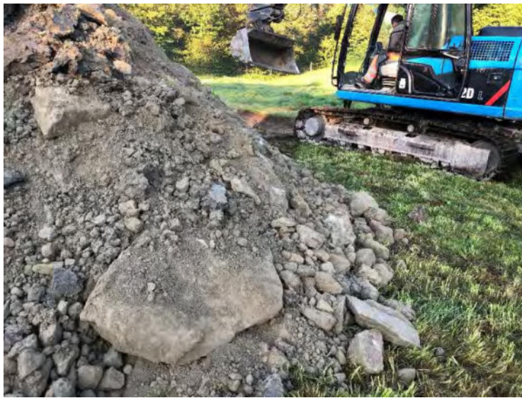
BS 2: Ausgehobenes Material, Blickrichtung SW
