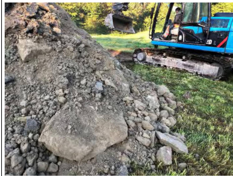
BS 2: Ausgehobenes Material, Blickrichtung SW
