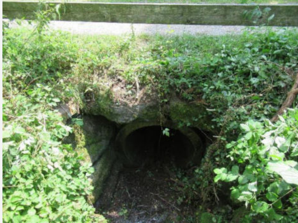
Einlaufbereich in Betonrohr bei Schlüsselstelle S1 (oeko-b ag, 28.07.2020).
