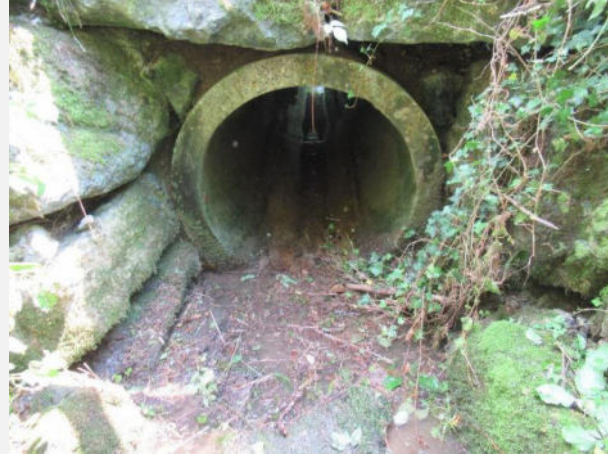
Einlaufbereich in Betonrohr bei Schlüsselstelle S1 (oeko-b ag, 28.07.2020).
