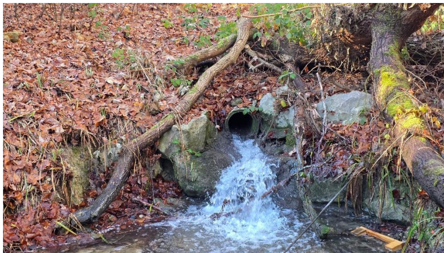
Abbildung 8: Auslauf DN 300 in Augraben
