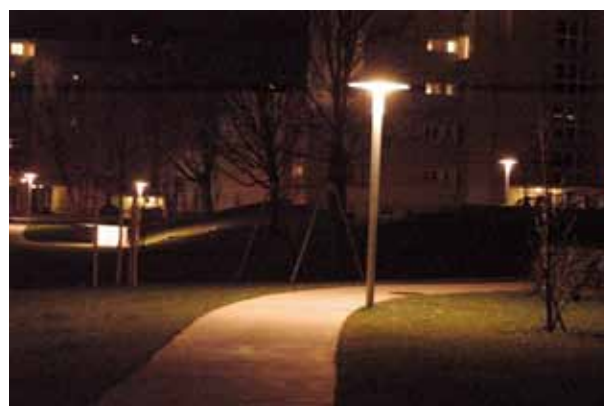
Beispiel: Beleuchtung Gehweg mit Masten
