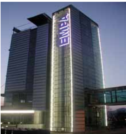
Beispiel: Beleuchtung Fassade
