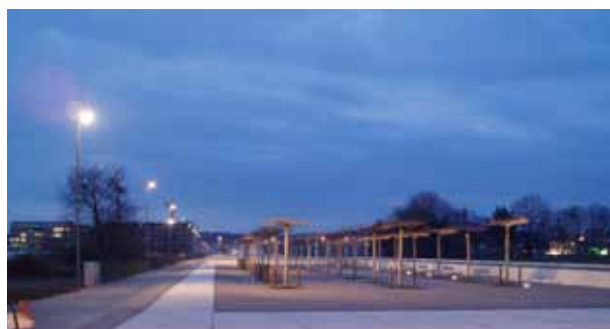
Beispiel: Beleuchtung Gehweg mit Masten
