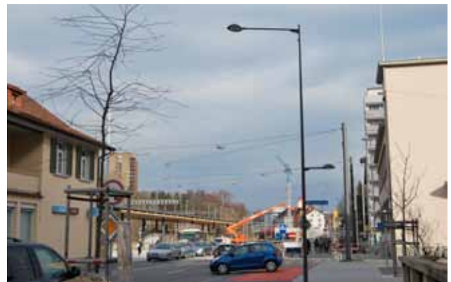
Beispiel: Beleuchtung Gehweg durch Mastansatzleuchten
