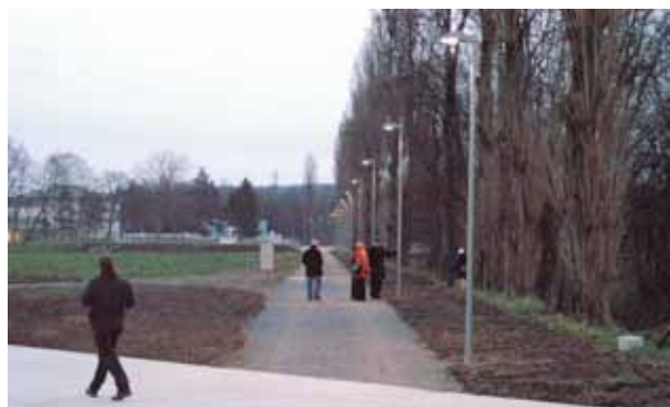
Beispiel: Beleuchtung Gehweg mit Masten
