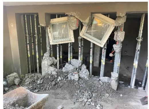
Abbildung 2; Abbruch ehemalige WC Anlage
