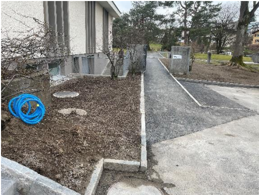
Abbildung 6; Ehemaliger Zugang WC-Anlage
