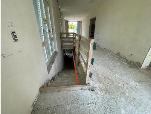
Abbildung 3; Rückbau Unterlagsboden
