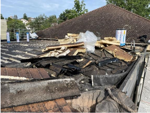
Abbildung 4; Sanierung Flachdach Besammlung
