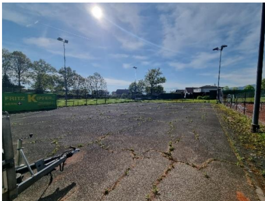
Asphaltplatz Quelle: Fotos Landis AG
