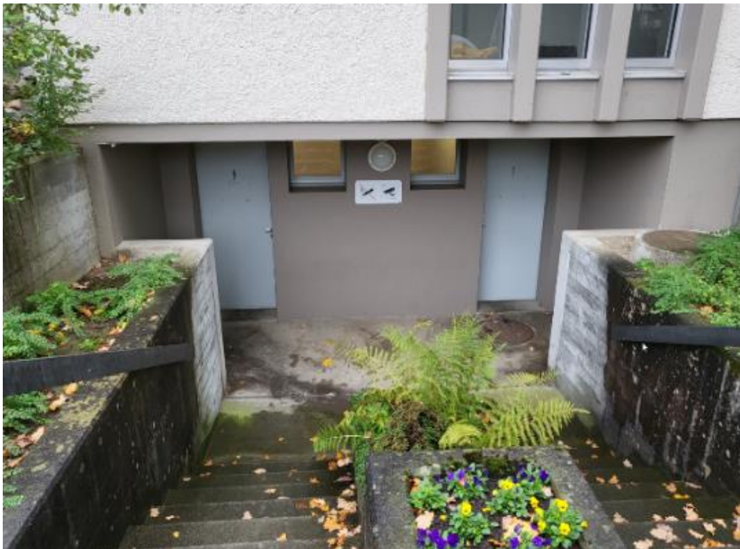
Abbildung 8; Bestehender Standort WC-Anlage
