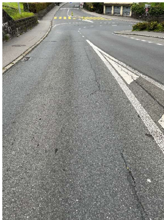
Abbildung 2: Bereich oberhalb Kurve
