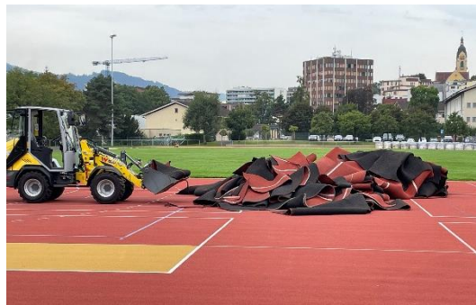
Abbildung 4: Rückbau Basisschicht
